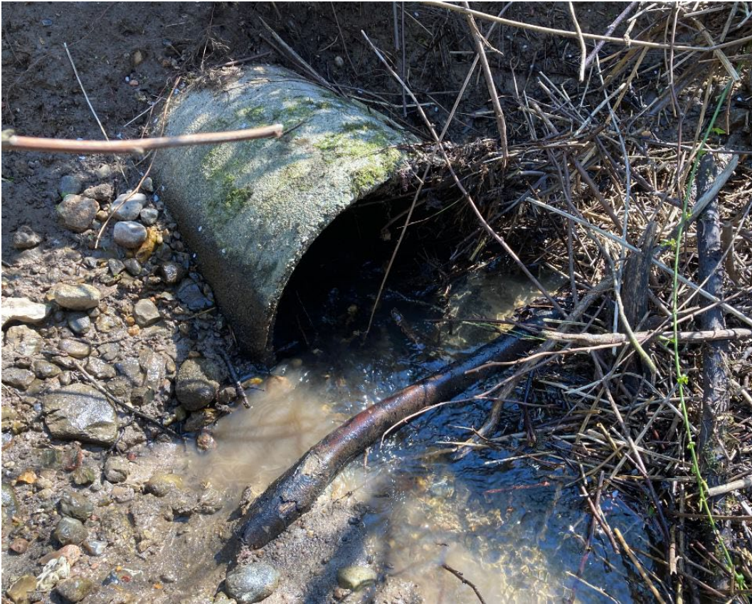
Figur 4. Indløb til den rørlagte strækning, april 2023.
